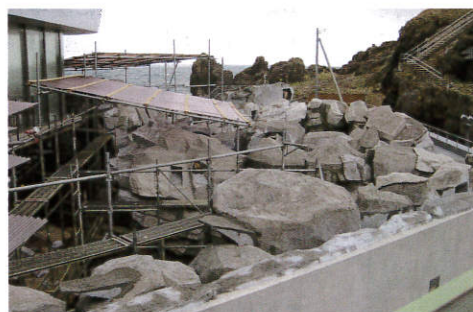
アシカプール・アザラシプールの完成前の様子
